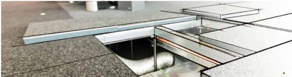
Der Vorteil der Herausnehmbarkeit bedingt, dass trotz genauester Passung zwischen den einzelnen Platten feine Fugen vorhanden sind. Ferner sind Aussparungen im Boden (für Steckdosen, Feuerlöschdosen, Staubsaugeranschlüsse etc.), durch die ebenfalls Wasser in den Installationsraum eindringen und dort Störungen hervorrufen könnte. Deshalb bei der Reinigung möglichst wenig Wasser verwenden. Keine Nassreinigung also!
